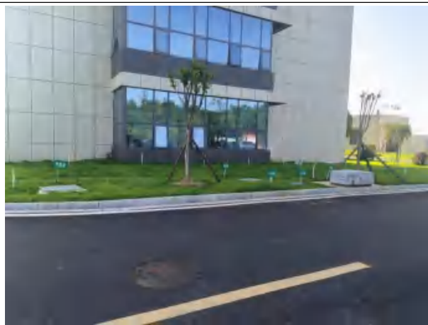
地埋式污水处理站
